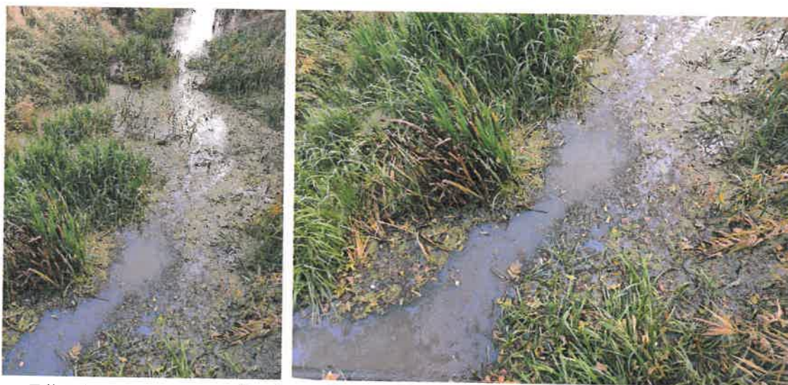
Zdj. 1 i 2 Koryto Kanału Sowina podczas poboru próbek w dn. 28.10.2024 r.
